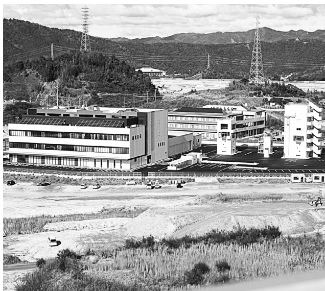
竣工間近のいわくに消防防災センター
