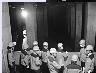
東池袋雨水調整池の調査
